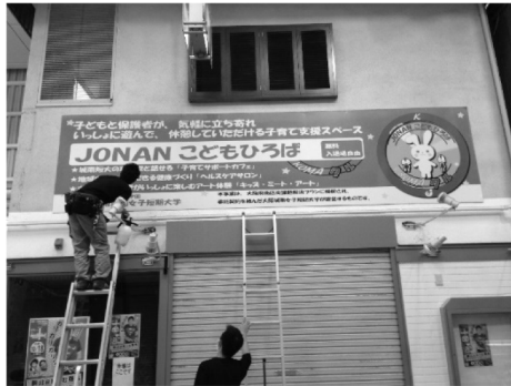
写真20 看板設置中の様子
